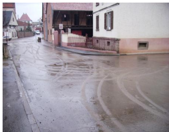
Figure 4 : Débordements des caniveaux et des avoires dans le centre du village
