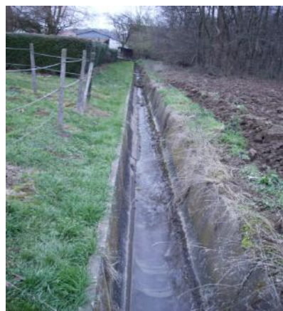
Figure 10 : Fossé busé en béton
